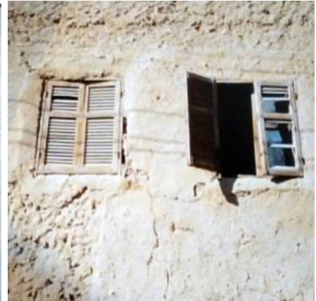
صورة (٢٣) واحة سيوة بمصر - هناك ملابس مختلفة للطلاء ب earth rendering من الناعم اللطيف الى الخشن.
