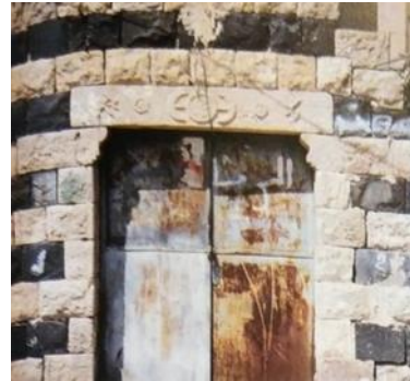
صورة (٧) بلدة Irbid بالاردن - البناء بحجر Ashlar masonry يتم تقطيعه بالمنشار او الازميل وهو من ٤ او ٥ او ٦ اوجه - البناء من طبقات من حجر البازلت basalt والحجر الجبرى lime وتم نقش السطح peripheral chiseling.
