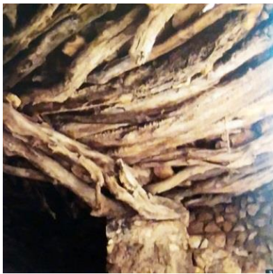
صورة (٢٨) تونس قرية Tamasred الطبقة الداعمة تصنع من الخامات الطبيعية المتاحة في البيئة المحيطة - مقصود ظهورها وتوزيعها وفق وزن الخامات المشكّلة للارضية - وعادة ما تستخدم وحدات بنائية مثل: القصب سواء مترابط او غير مترابط او في شكل حصيرة منضفرة mat form و جذوع النخل وريش الدجاج feather grass .
