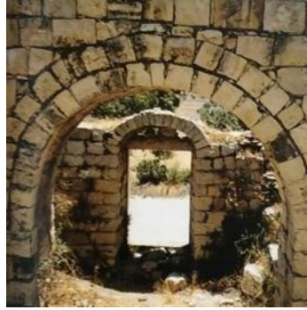
صورة (٨) رام الله بفلسطين تقنية البناء بالحجر dressed quarry stone.
