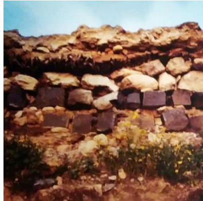
صورة (٢٨) تونس قرية Tamasred الطبقة الداعمة تصنع من الخامات الطبيعية المتاحة في البيئة المحيطة - مقصود ظهورها وتوزيعها وفق وزن الخامات المشكّلة للارضية - وعادة ما تستخدم وحدات بنائية مثل: القصب سواء مترابط او غير مترابط او في شكل حصيرة منضفرة mat form و جذوع النخل وريش الدجاج feather grass .
