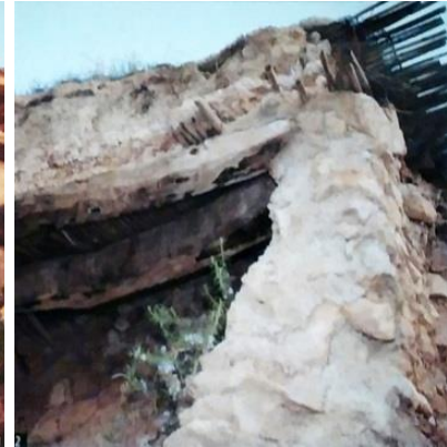
صورة (٢٦ و ٢٧) الاردن بلدة Fuhais - طبقات سميكة معقدة - هذا النوع مكون من ثلاث طبقات هي: طبقة بنائية من جذوع النخل structural layer وطبقة داعمة ما اطار للصب sacrifice framework وطبقة الحشو filling layer التي تكون الارضية الحقيقية.
